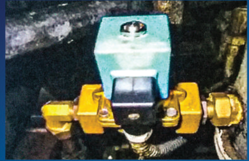
بعد از تمیزکاری با آیس بلاست
